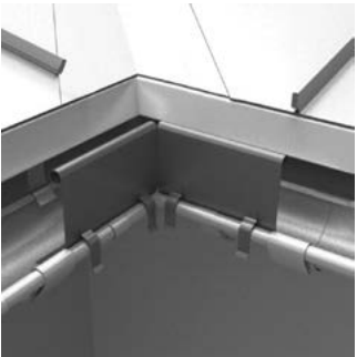
Екран переповнення ринви кутовий Цей екран встановлюється навпроти внутрішніх стиків (єндів) для запобігання переливу ринв.
