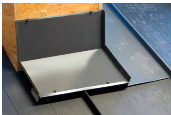
Obr. e – osadenie čelového oplechovania z hladkého plechu a jeho uchytenie k vetracím profilom a zafalcovanie k druhej šablóne.
