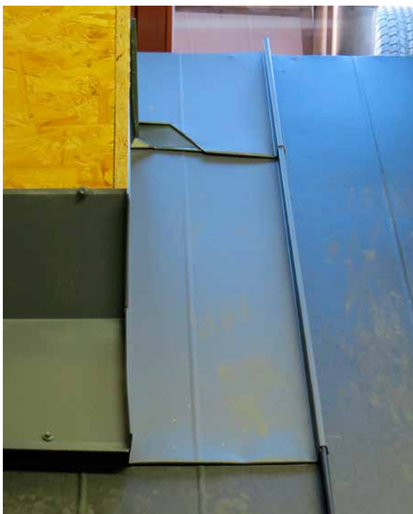
Obr. i, j – osadenie a zaháknutie tretej šablóny o zadné oplechovanie.
