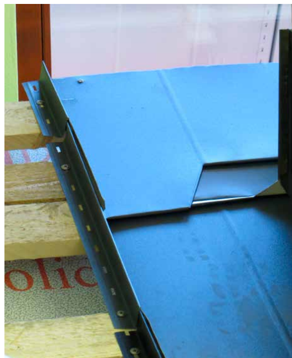
Obr. g, h – osadenie zadného oplechovania vyhotoveného z hladkého plechu.
