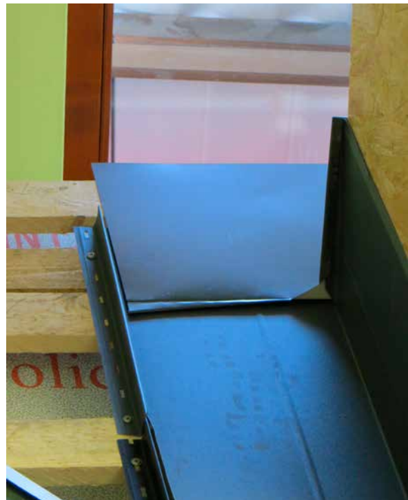
Obr. g, h – osadenie zadného oplechovania vyhotoveného z hladkého plechu.
