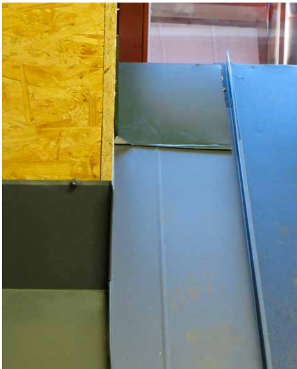
Obr. g, h – osadenie zadného oplechovania vyhotoveného z hladkého plechu.
