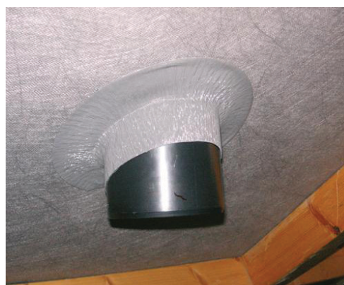
19. Attēls Ventilācijas skursteņa blīvēšana ar Easy Form blīvlenti
