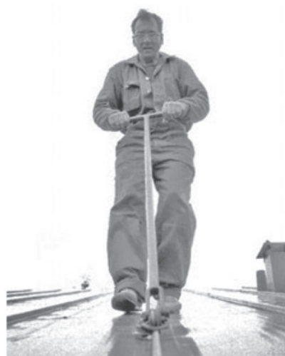
Püstõmbluse mehhaniseeritud valtsimine.
