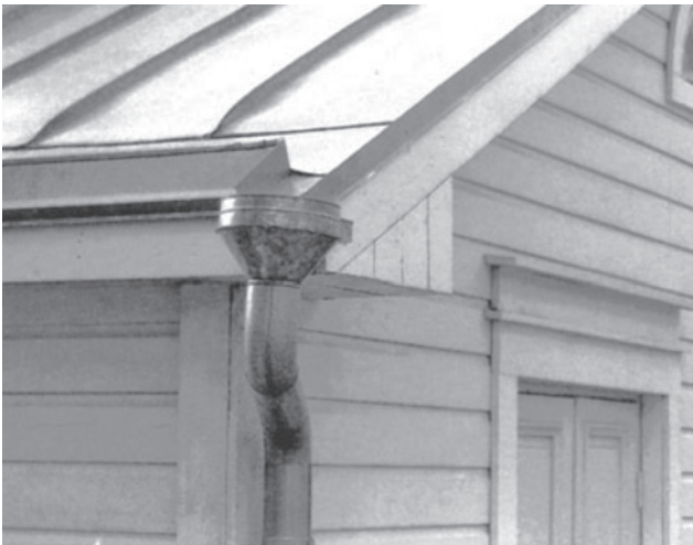
Veetõkke ja otsaräästa ühinemiskohal olev veesüli koos veetõruga.
