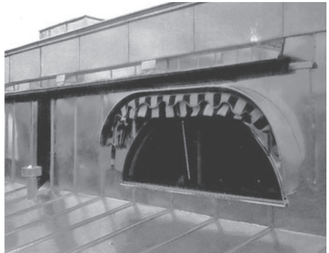
Plekk-katusega liituv sein ja selle ülaservas olev plekitatud tala.
