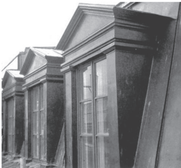
Katuseplekituse liitumine akendega, millel on mitmesuguseid detaile.
