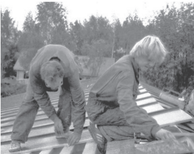
Plekitahvlite kinnitamine ribadega.
