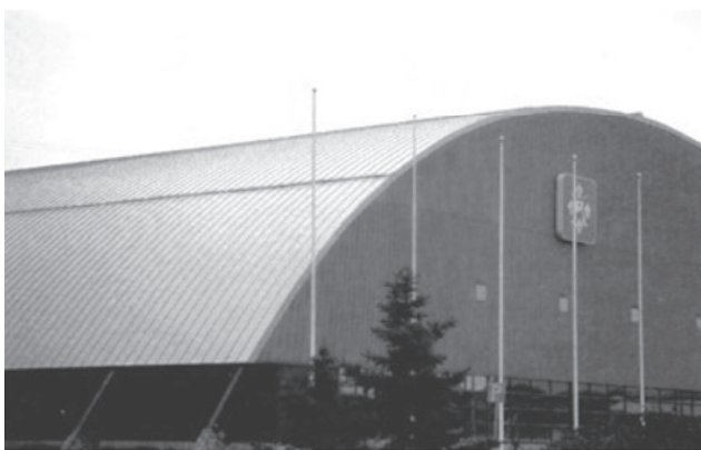
Pikkadel viiludel tehakse liikuvad valtsühendused.
