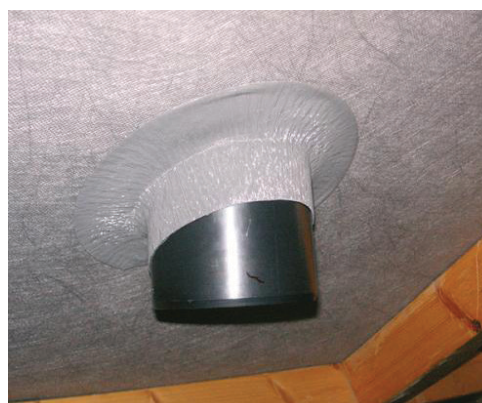
Pilt 19. Tuulutuskorstna tihendamine Easy Form tihendusteibiga
