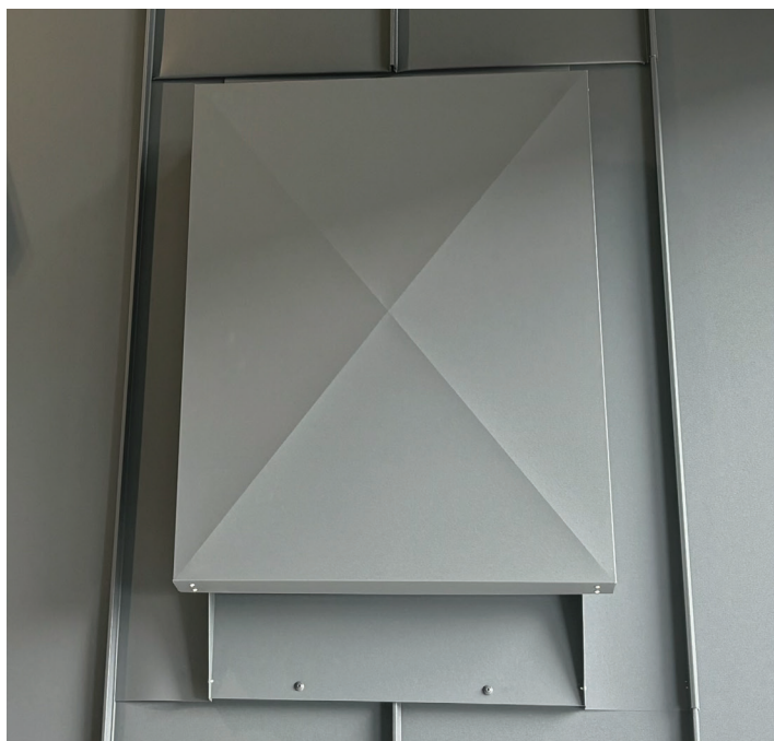
Pilt 1. Paigaldatud katuse luuk
