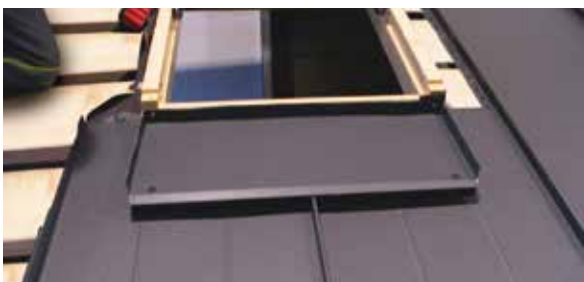
Zhotovení čelového oplechování z hladkého plechu a jeho přichycení k větracím profilům a oknu. Osazení boční šablony, vytvarované do potřebného tvaru.
