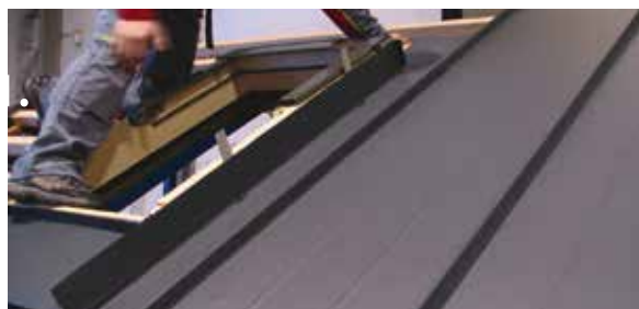
Zhotovení čelového oplechování z hladkého plechu a jeho přichycení k větracím profilům a oknu. Osazení boční šablony, vytvarované do potřebného tvaru.
