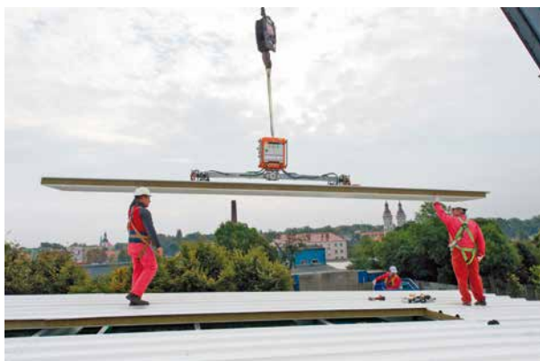
Obr. 8 a 9. Montáž strešných panelov.
