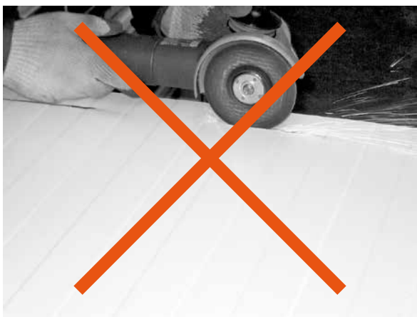
Obr. 6 a 7 Panely nerežte uhlovou brúskou, pretože môže dôjsť k zničeniu antikorózných krytov
