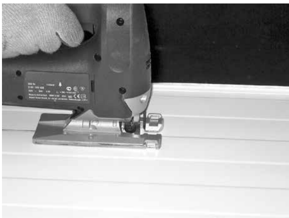
Obr. 4 a 5. Pro řezání panelů se doporučují pily.
