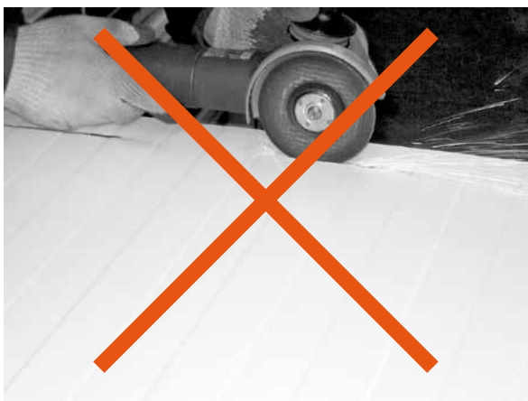
Obr. 6 a 7 Panely neřežte úhlovou bruskou, protože může dojít ke zničení antikorozních krytů.
