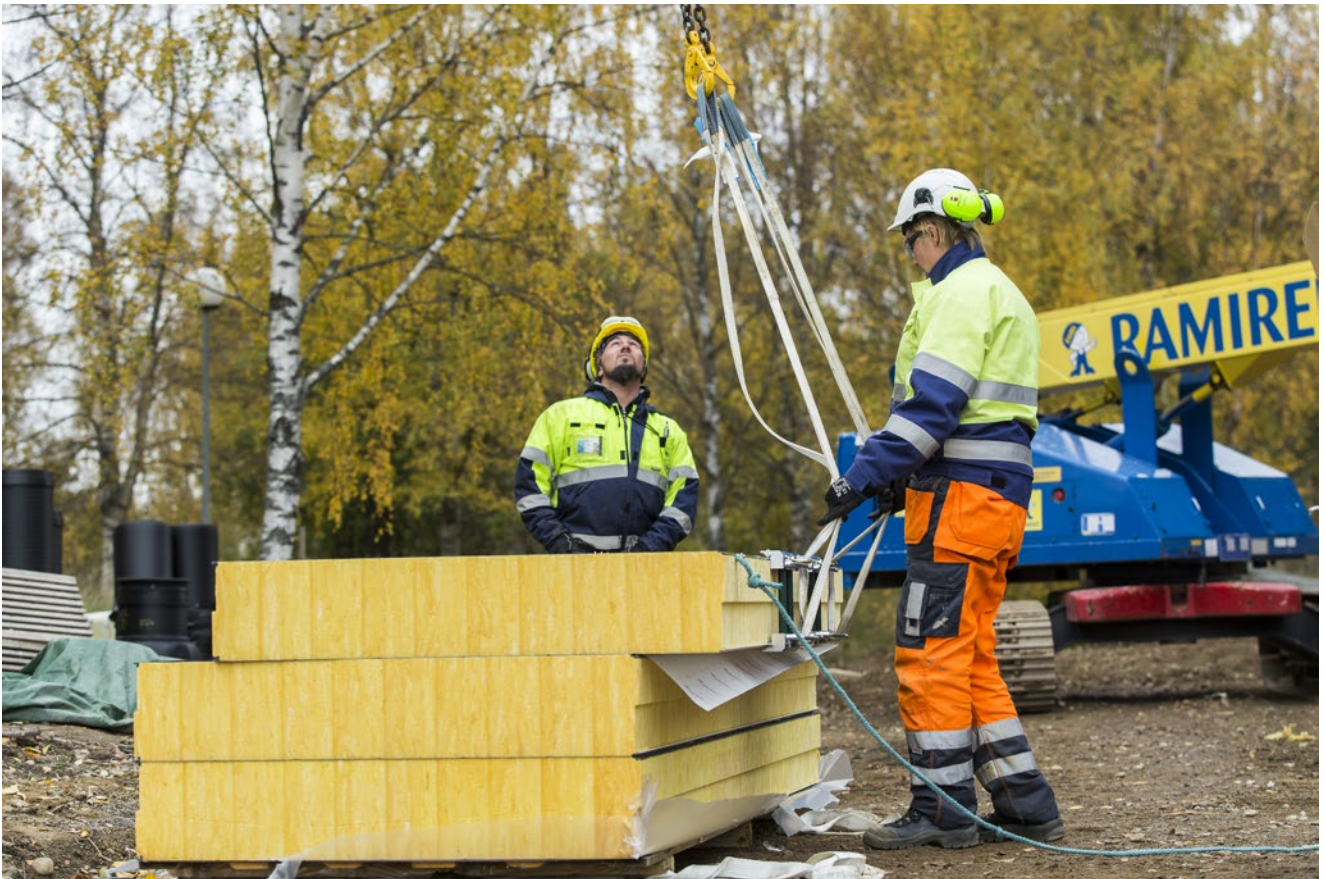
Kuva 7. Paneelinippujen purkaminen.
