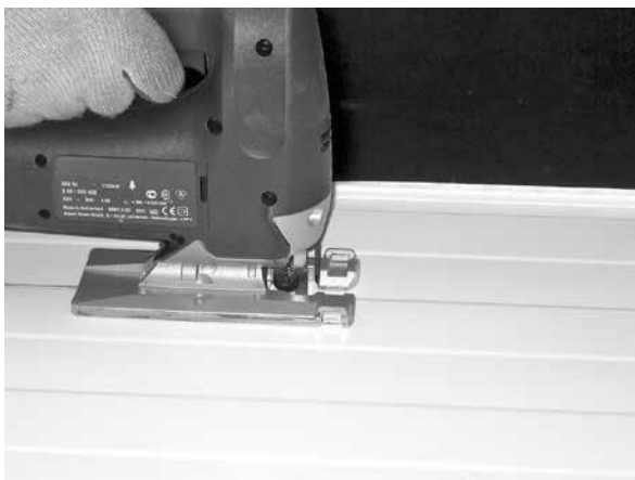
Fot. nr 4 i 5. Do cięcia płyt zaleca się stosowanie pilarek.
