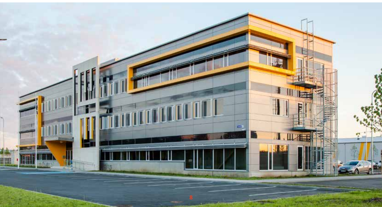
płyty ścienne z łącznikiem widocznym nSPB (gr. 100 – 230 mm)
