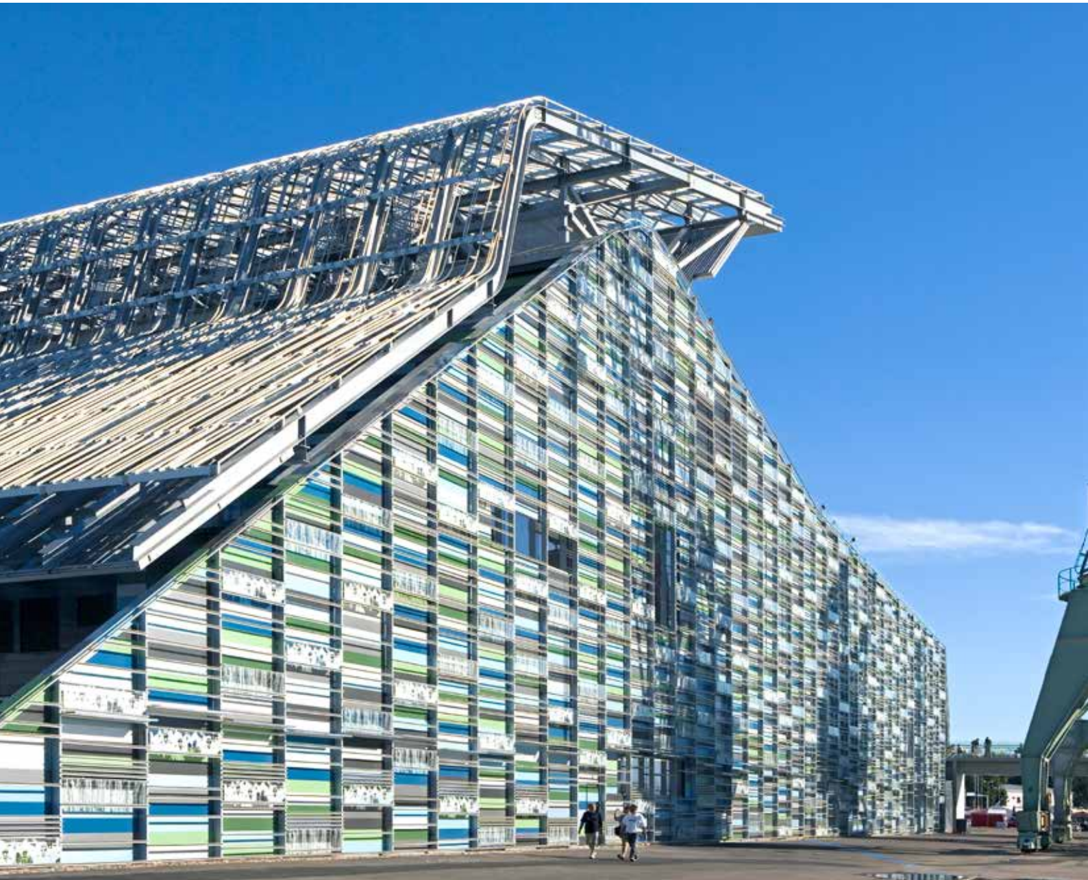
Maritime Centre Vellamo, Kotka, Finlandia. Produkty elewacyjne Ruukki: Lamella Groove 20.
