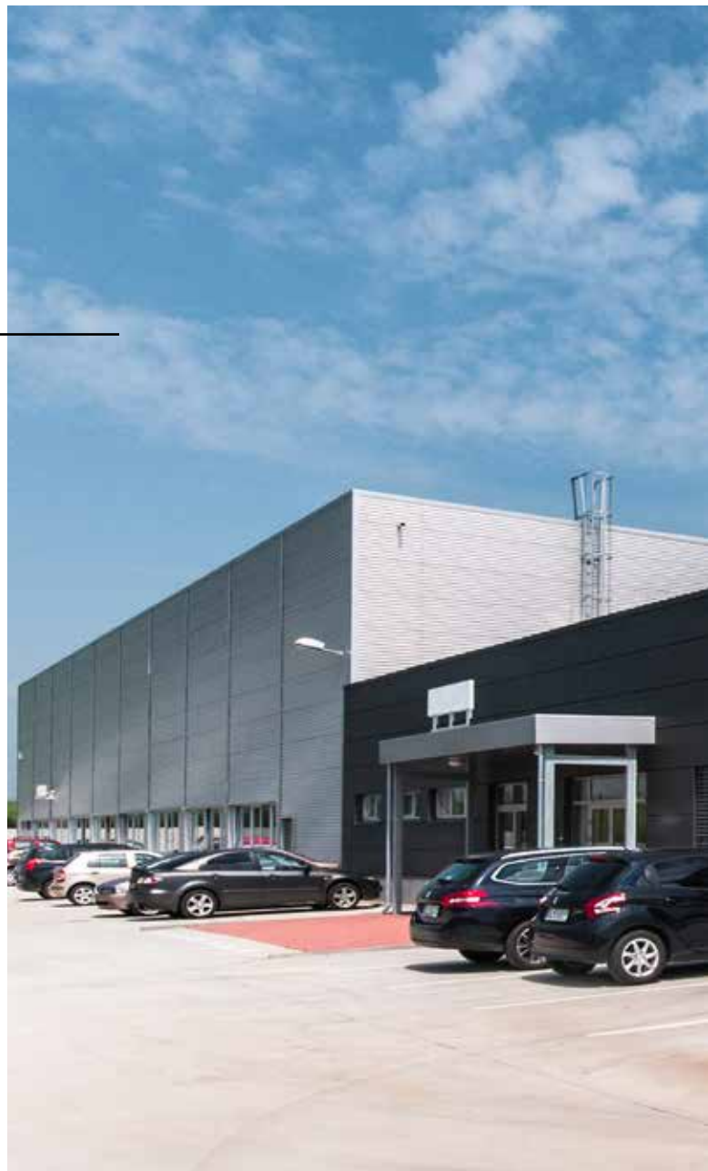
Centrum logistyczne, Klasov, Słowacja. System Ruukki Forma z kasetonami Liberta Elegant 500 Grande
