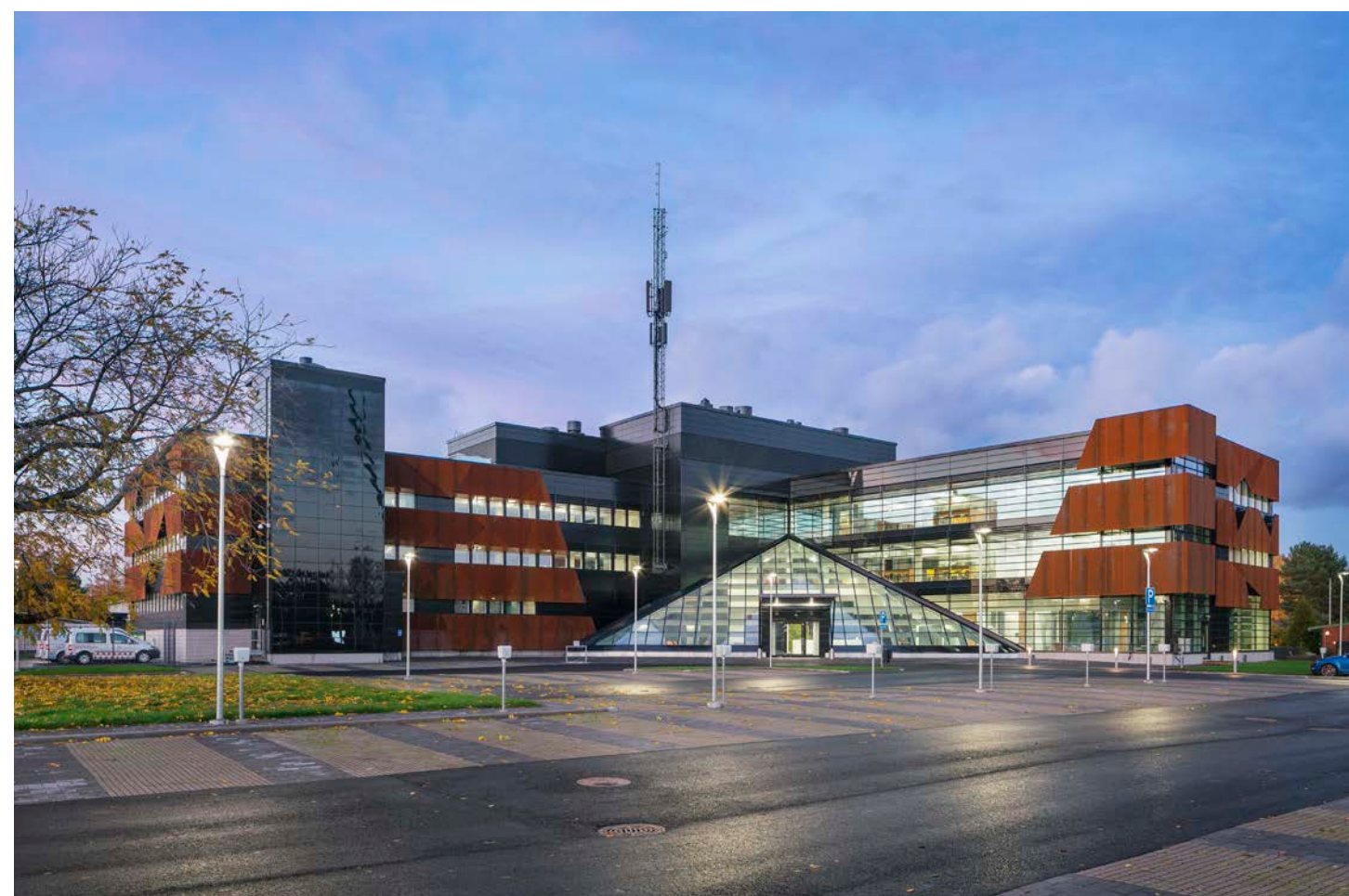
Irodaépület, Vantaa, Finnország. A Ruukki homlokzat termékei: Liberta™ Solar.
