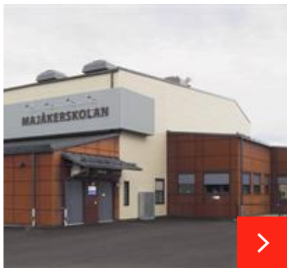
Veřejná budova – škola Majåkerskolan
